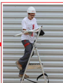
Soulever verticalement le garde-corps de façon à passer en dessous.
