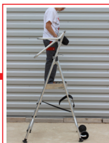
Avancer sur le plancher en rabattant derrière vous le garde-corps.
