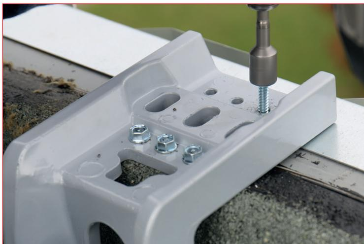
Fijación en petril acero con tornillos auto-roscantes Ø 6,3 x 30.
