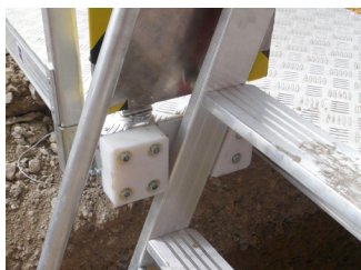
TAQUET POLYAMIDE POUR ASSURER LE GUIDAGE ET L'INCLINAISON DE L'ÉCHELLE
