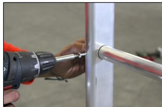
2.5 Serrage des poteaux. Serrez les vis pointeau des supports à l'aide d'une clé Allen de 5mm.
