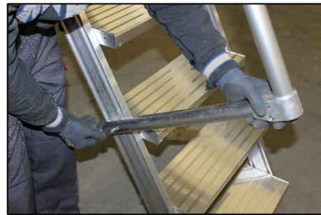
3.4 B Serrage des pièces de liaison avec clé Allen
